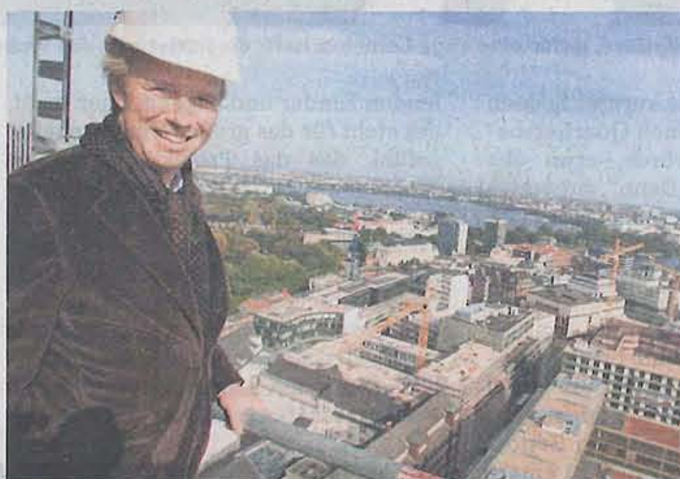
Hans-Christoph Klaiber auf der Baustelle des Ex-Unilever-Hauses, das aufwendig umgebaut wird
